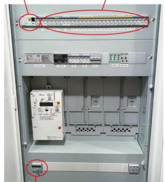
Vorzählersicherung / Tarifschalter
